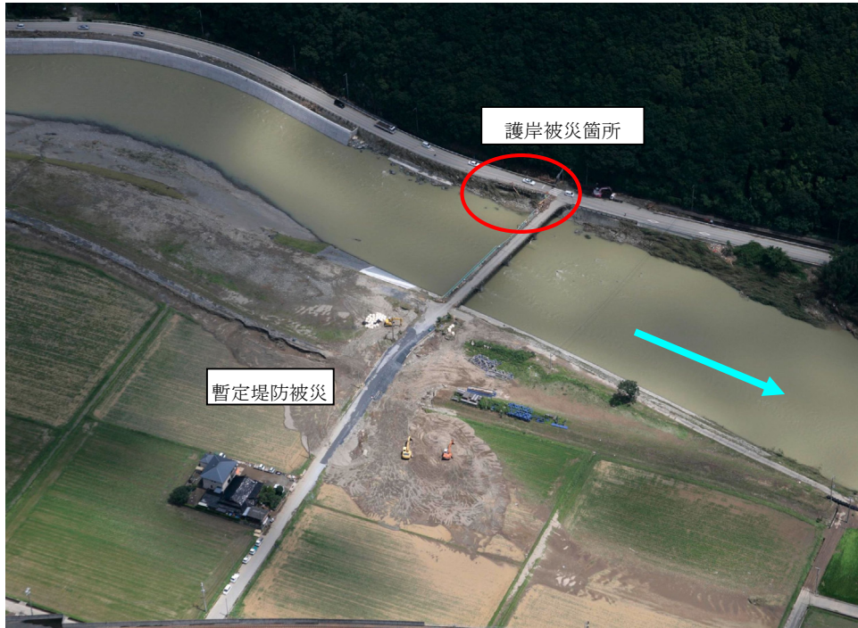
図 3.6 河野原地区被災状況空中写真（国際航業提供）
