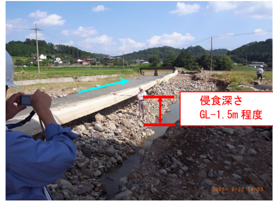
上流側より堤防を望む
