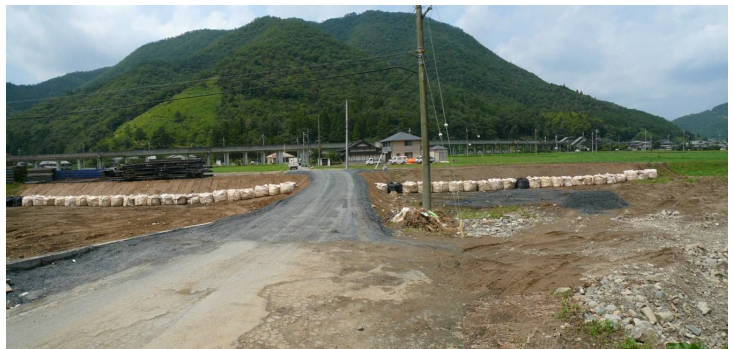
図 2.13 右岸堤内地状況
