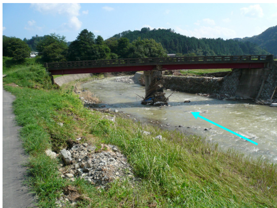
上流側より殿町橋を望む（兩岸へ越流していたことが推測される）
