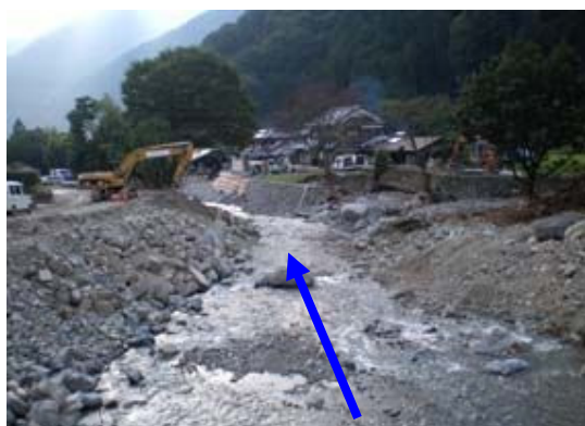
図 2.65 橋梁下流側河川状況
