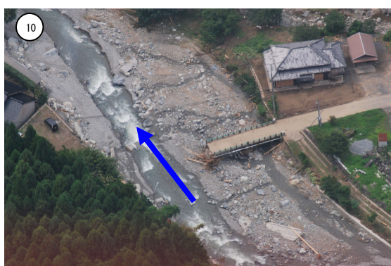
図 2.63 橋梁流失 (兵庫県提供)
