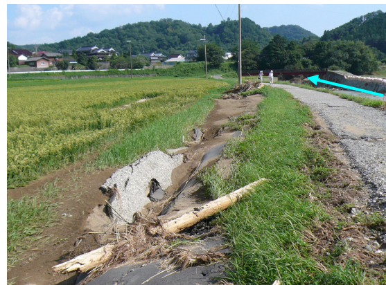
上流側より左岸堤防を望む
