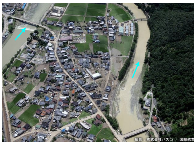
図 2.22 久崎地区被災状況
