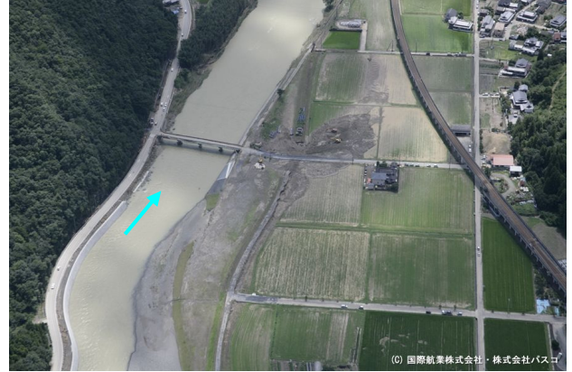
図 2.10 被災状況航空写真 1)
