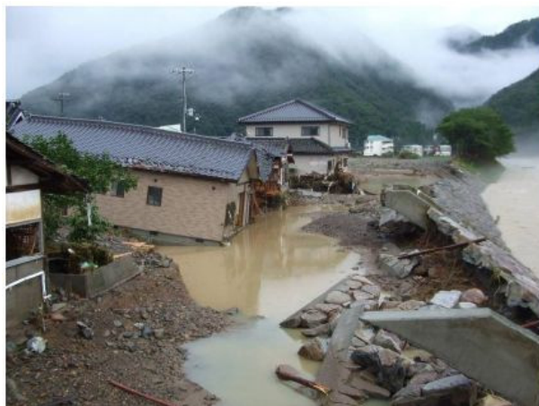
図 2.20 堤防被災状況 (兵庫県提供)
