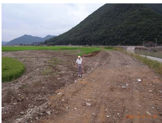
図 2.6 越水箇所被災状況 (①-2)
