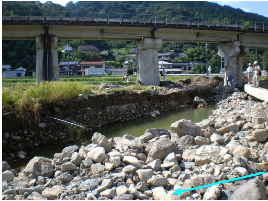
下流側より堤内地側を望む
