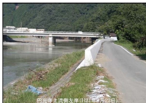
図 2.32 堤内→堤外流下箇所（下流側）
