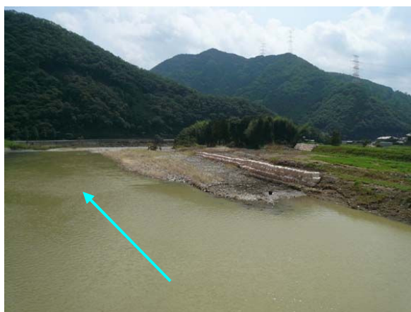
図 2.16 越流箇所被災状況
