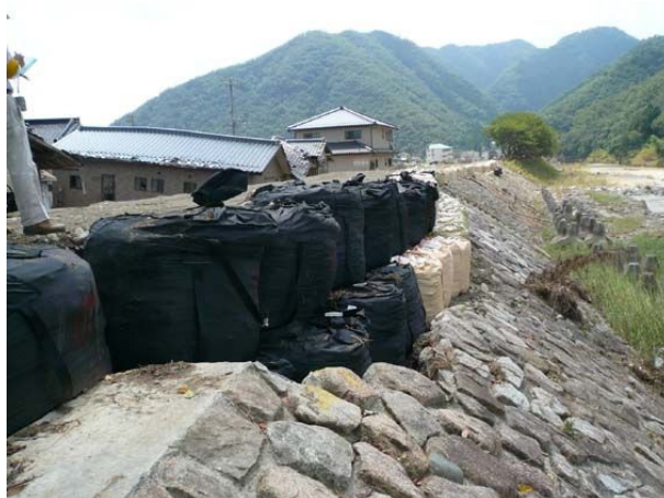
図 2.21 堤防川表側状況
