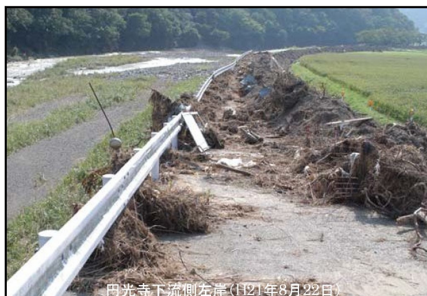
図 2.31 堤内→堤外流下箇所（下流側）
