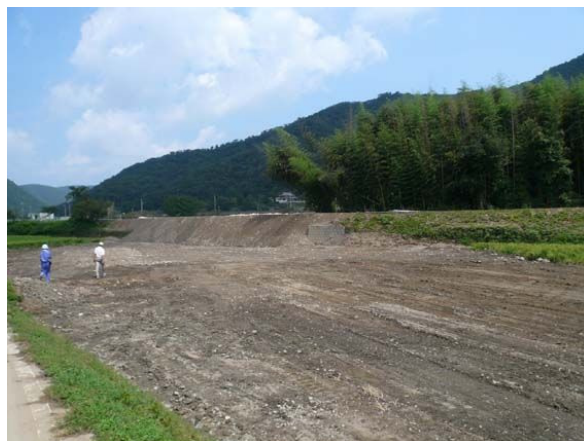
図 2.15 越流箇所被災状況
