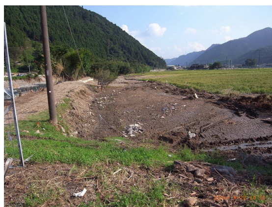
(d) 木坂橋右岸下流側
