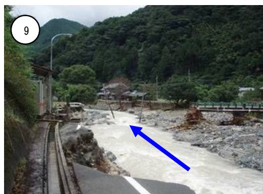
図 2.64 道路, 橋梁の流失 (兵庫県提供)
