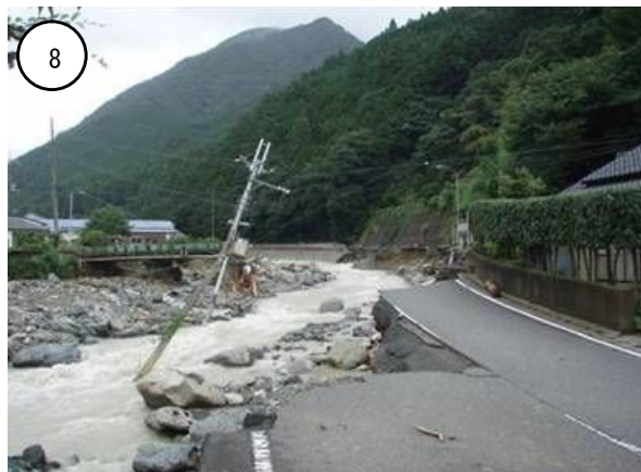
図 3.35 道路兼用護岸流失(兵庫県提供)
